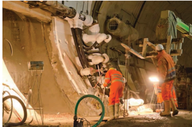
Bild 6: Querschlagsvereisung Finnetunnel; Neubau- strecke Erfurt-Halle/Leipzig
